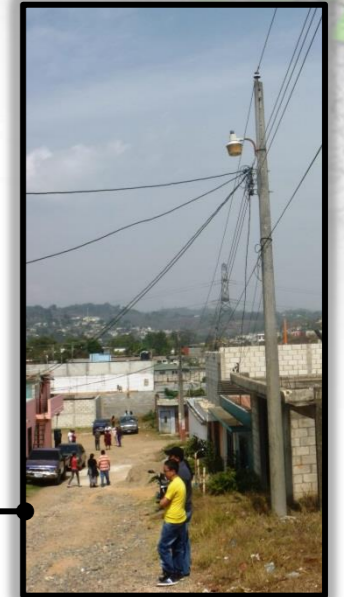
Vista 2da calle en dirección Este-Oeste. Resaltado el poste de electricidad donde actualmente se tiene conectada la acometida eléctrica de la Iglesia. No. De poste 501525
