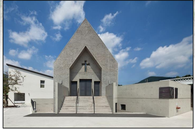
Figura No. 35 Fotografía exterior desde la plaza de la Iglesia Católica de Inbu Fuente: Yoon, Joonhwan
