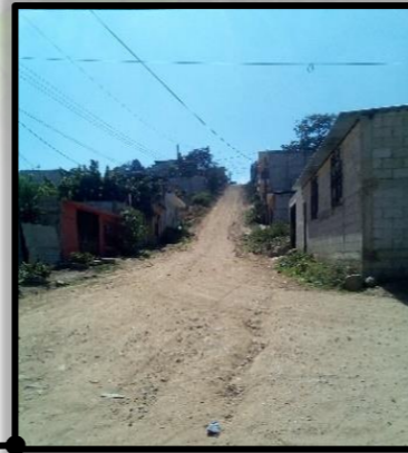
Vista de la 1ra calle, tiene un ancho de 6.60 metros promedio de acera a acera con un pendiente de 30% aproximadamente. En esta calle son muy pocas las casas que tiene acera. Esta calle al terminar la pendiente tiene tope.
