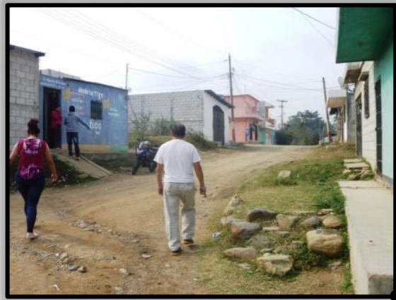
Vista de avenida "A" desde esquina contraria a RD GUA-20 Tiene un ancho de 6.50 metros promedio de acera a acera y es de doble vía. Relativamente tiene una pendiente aproximada de 3%.
