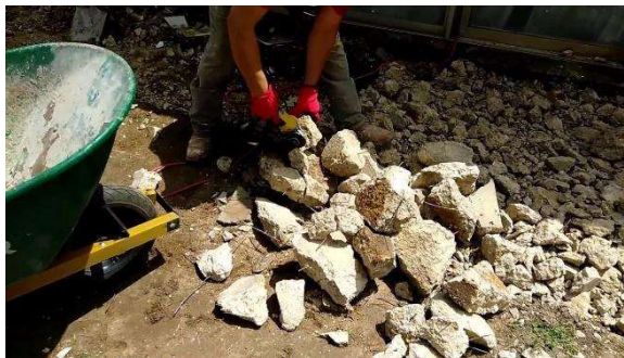
Figura 3. Trituración manual residuos de concreto
