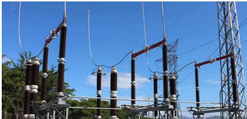
Figura 9. Seccionadores de línea de apertura central
