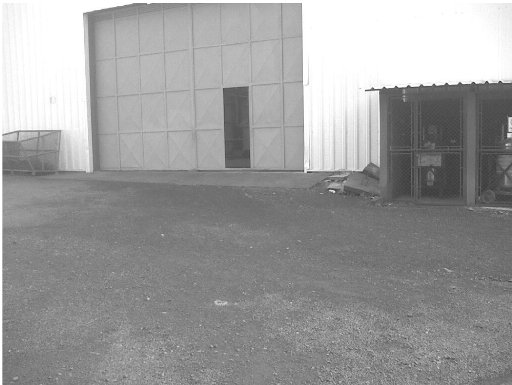
Figura 4. Terracería en los alrededores de la nave de producción
