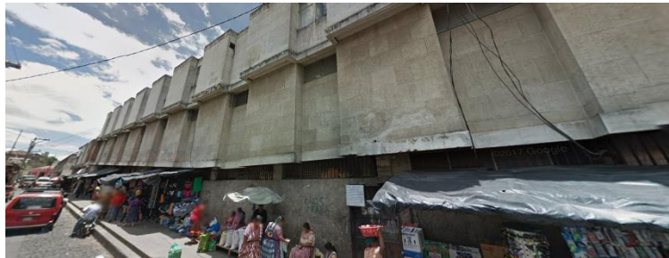
Figura 11: Fachada Sur, Centro comercial municipal de Quetzaltenango, 8va calle zona 1. Fotografía de: Fabiola Oxlaj, año 2021
