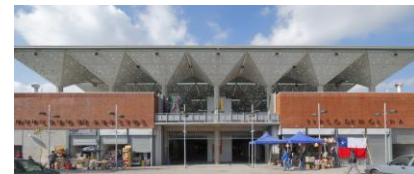
Figura 10: fotografía: fachada de ingreso principal, se aprecia el contraste de sus elementos formales.
