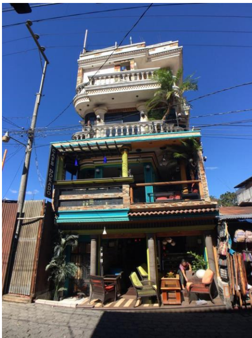
Figura 52: fotografía de edificio de uso versátil en las calles principales del casco urbano de Santiago Atitlán.
