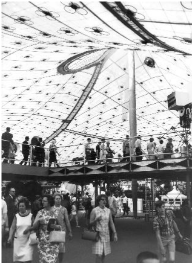
Fig. #1. Foto desde el interior del pabellón mostrando la estructura principal. El cual trabaja por medio de equilibrio a partir de una columna de acero. Fuente: https://www.plataformaarquitectura.cl/cl/768540/clasicos-de-arquitectura-pabellon-
