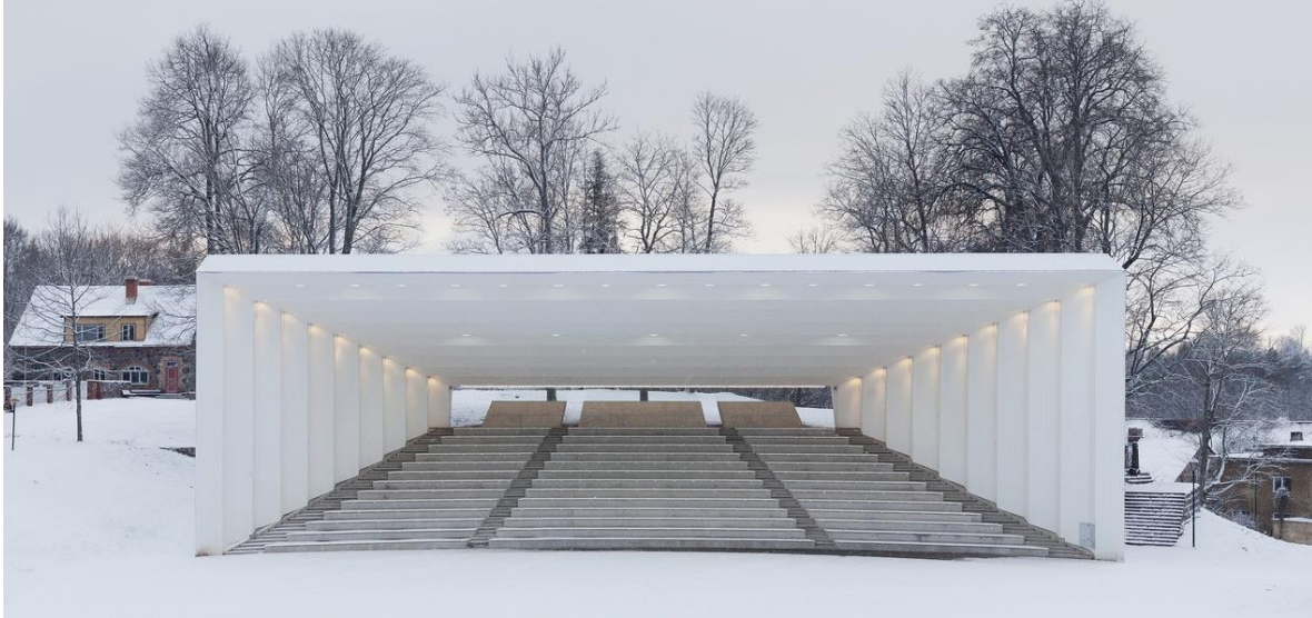
Fig. #7. Elevación principal de Artes escénicas Viljandimaa, Estonia, Fuente: https://www.plataformaarquitectura.cl/cl/760852/viljandi-festival-arena-kadarik-tuur-arhitektid
