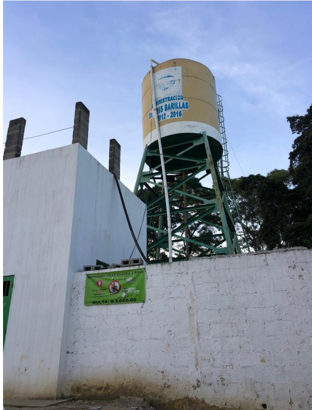
Figura 2. Tanque de almacenamiento colonia San Antonio
