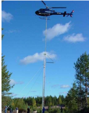
Figura 31. Helicóptero transportando una torre de transmisión de emergencia
