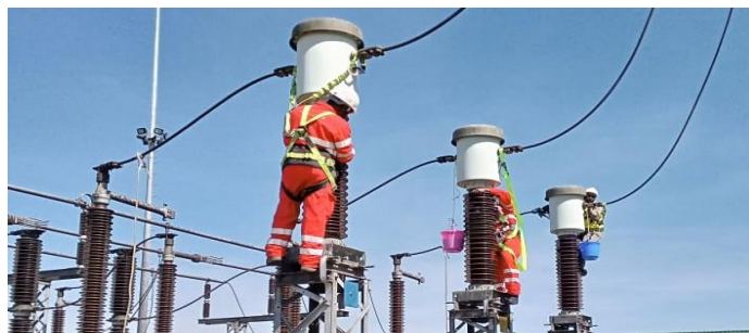
Figura 12. Limpieza de aislamiento para prevenir descargas por contaminación
