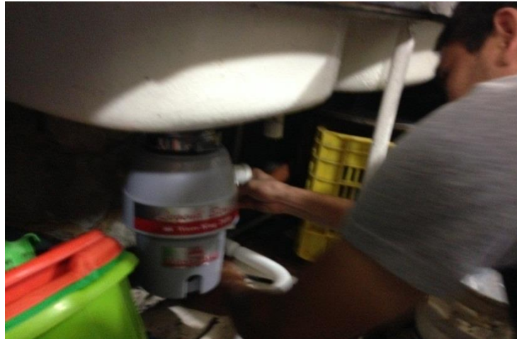
Figura 4. Colocación de TDC
