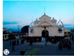
Se observa una vista de la iglesia católica la cual es el centro del municipio de Santa Cruz Balanyá.
