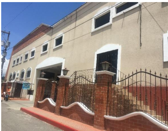
Imagen No. 22: Ingreso a sótanos Fuente: propia
