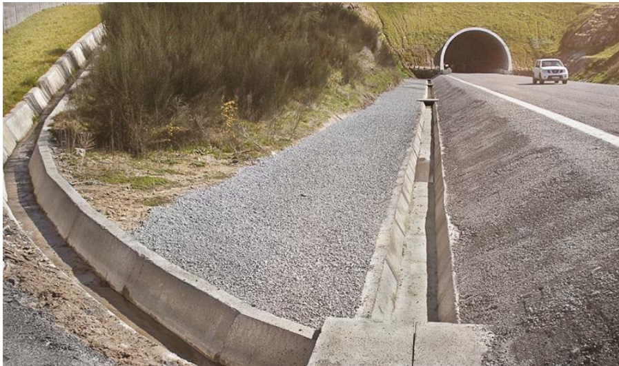
Figura 8. Drenaje longitudinal en carreteras
