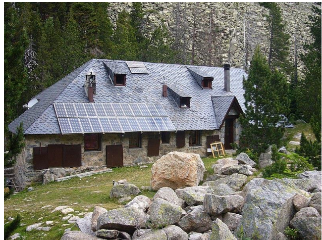
Figura 16. Refugio del Estany Llong alimentado mediante energía solar Fuente:
