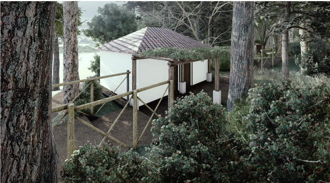
Figura 67. Vista módulo de servicios sanitarios Fuente: elaboración propia
