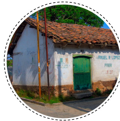
Ilustración No. 36 - Tipología de Vivienda techo de teja San José Fuente: Captura propia
