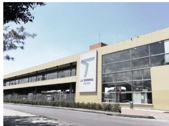
Figura 16. Fachada frontal, Terminal del Sur, Bogotá Fuente: https://www.terminaldetransporte.gov.co/ .
