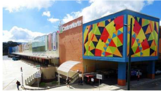
Figura 21. Fachada frontal y lateral de Centra Norte Fuente: https://www.guatemalagbc.org/info/centra-norte/ .
