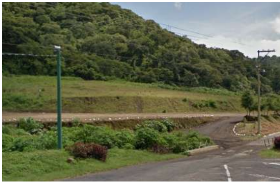
Figura 57. Servicios de cableado eléctrico frente al ingreso del proyecto
