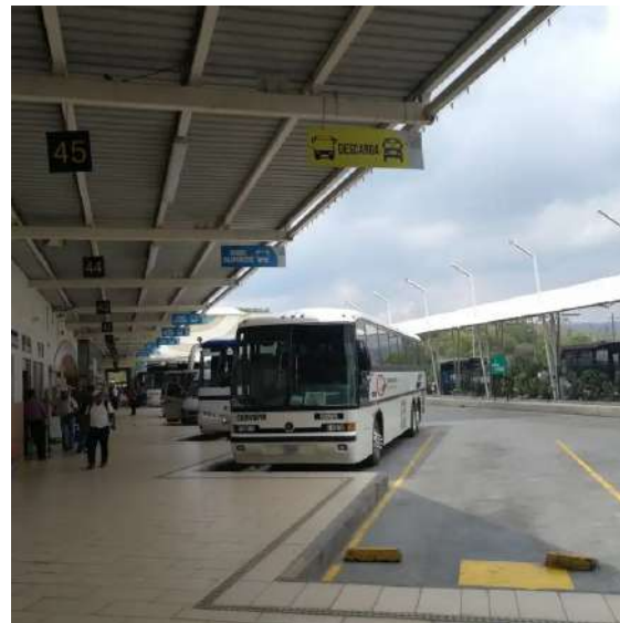
Figura 22. Área de andenes de buses con estructura metálica para el techado del espacio Fuente: Elaboración propia
