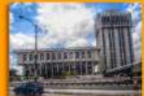
Consta de dos módulos rectangulares con fachada en hormigón con implementación de parteluces en su fachada Norte y Sur.
