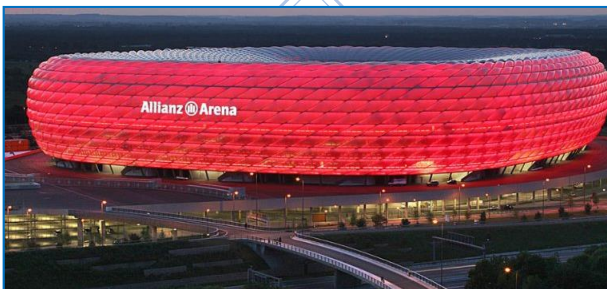
Figura 24 Fachada estadio Allianz Arena, Alemania, la cual posee un sistema de pantallas de luz Led dinámicas capaces de reproducir hasta 16 millones de colores.
