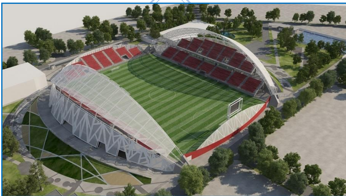
Figura 42 Vista de conjunto.
