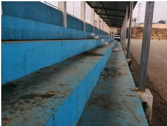
Figura 70 Estado actual de graderío.
