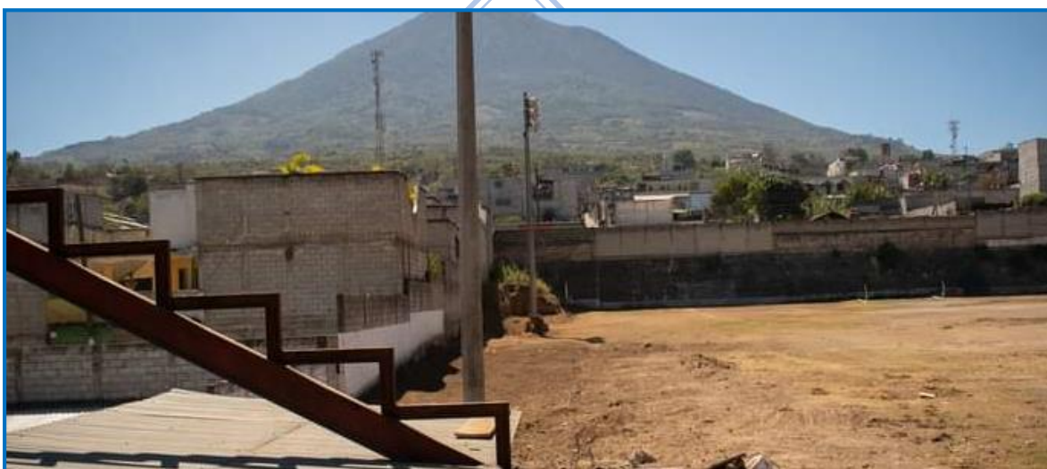
Figura 48 Inicio de los trabajos de Demolición.
