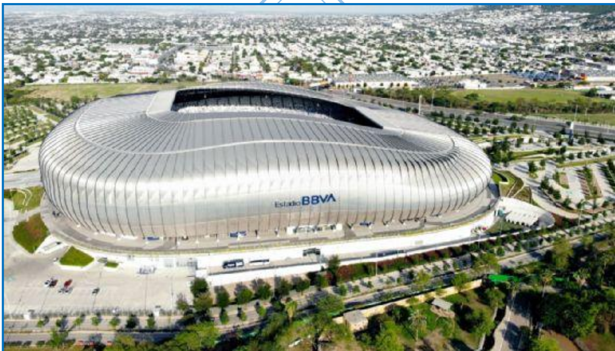
Figura 20 Envolventes, estadio BBVA de Monterrey, México.
