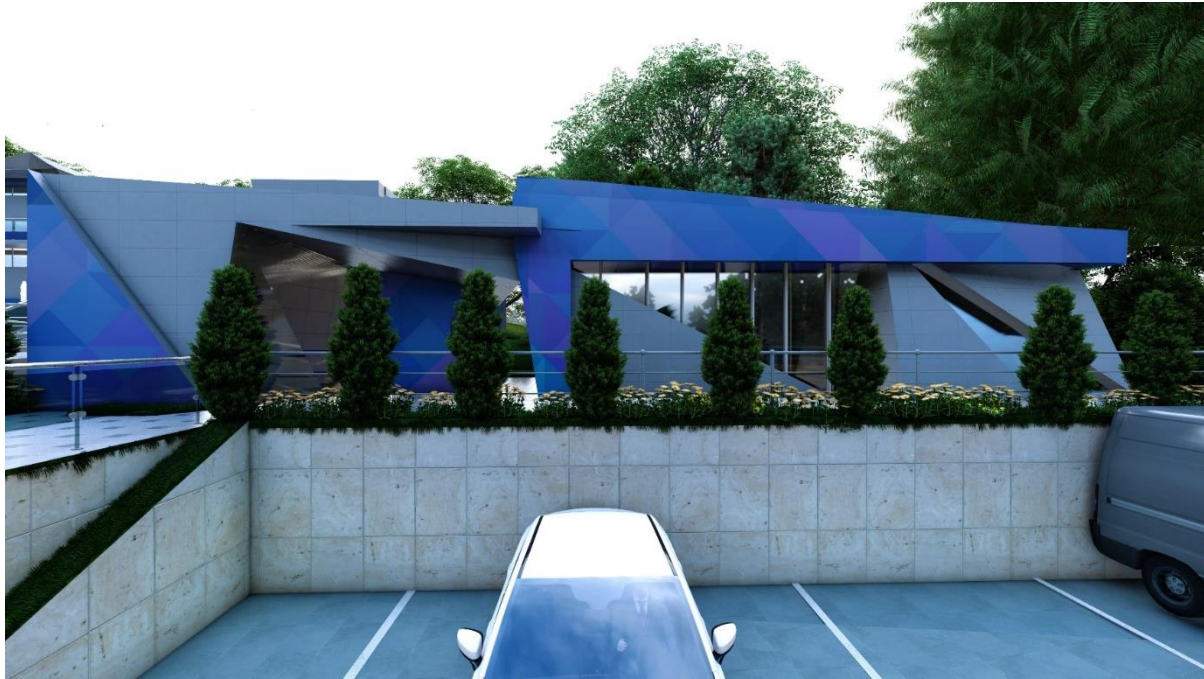
Figura No. 25 Fachada área de servicio Elaboración: Marvin Toc
