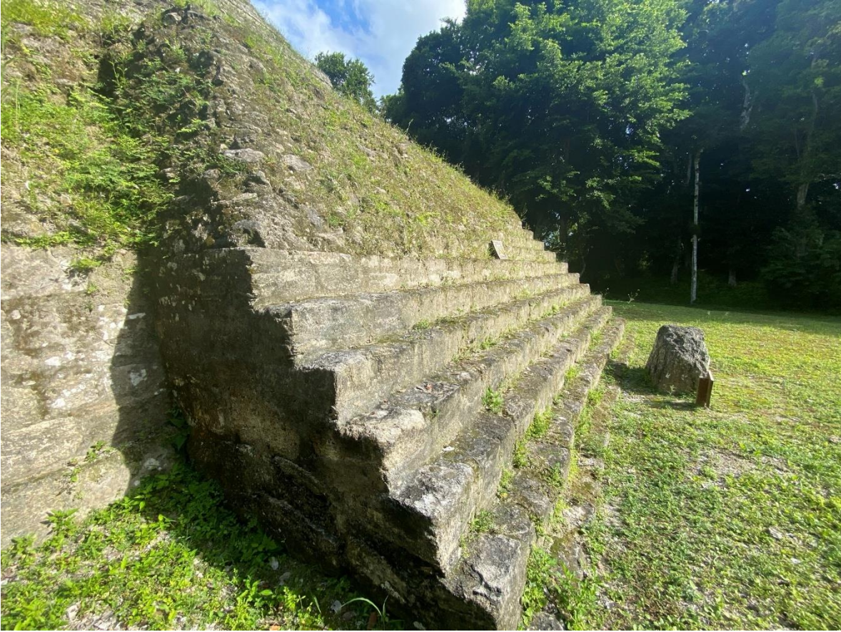
Figura 7. Escalinata norte, Edificio 216, Yaxhá, Petén, Guatemala Fotografía: Wendy Estrada, septiembre 2021
