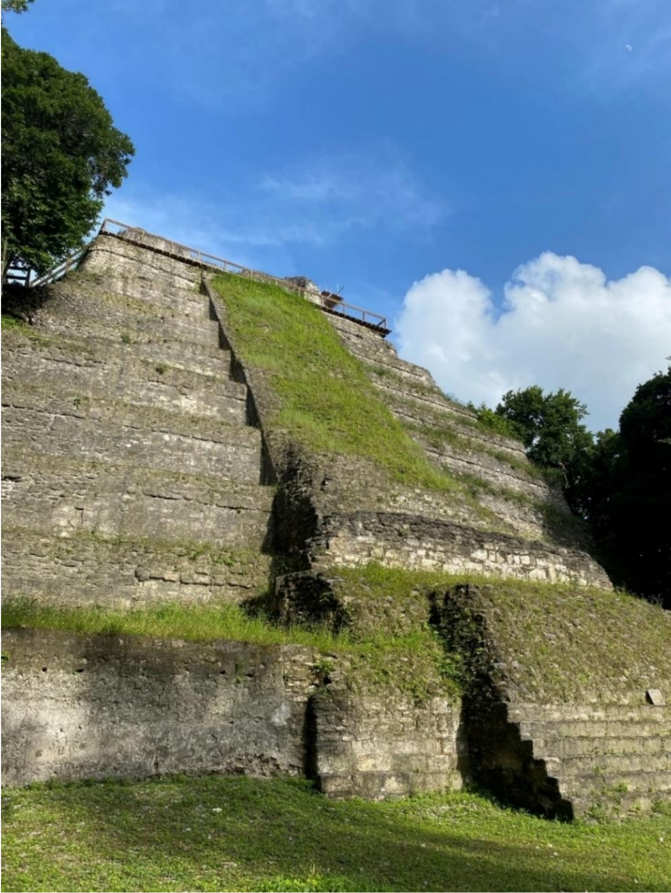
Figura 4. Escalinata norte, Edificio 216, Yaxhá, Petén, Guatemala Fotografía: Wendy Estrada, septiembre 2021
