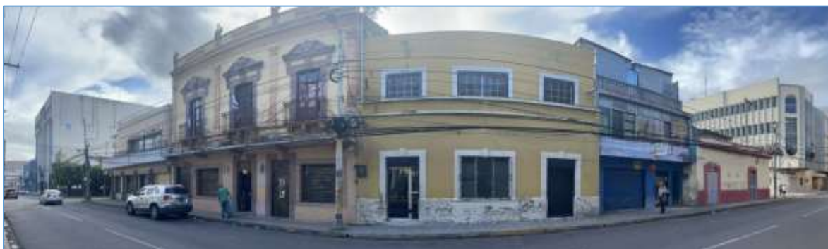
Figura 49. Panorámica de fachadas de bloque 11. Fuente: Fotografía propia. Mayo de 2022.
