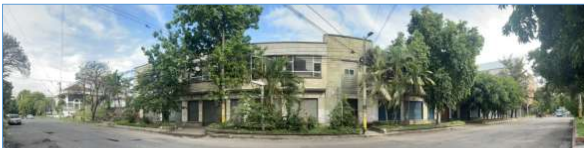
Figura 39. Panorámica de fachadas de bloque 6. Fuente: Fotografía propia. Mayo de 2022.
