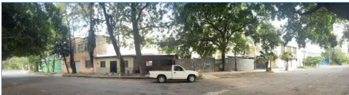
Figura 30. Panorámica de fachadas del bloque 2 Fuente: Fotografía propia. Mayo de 2022
