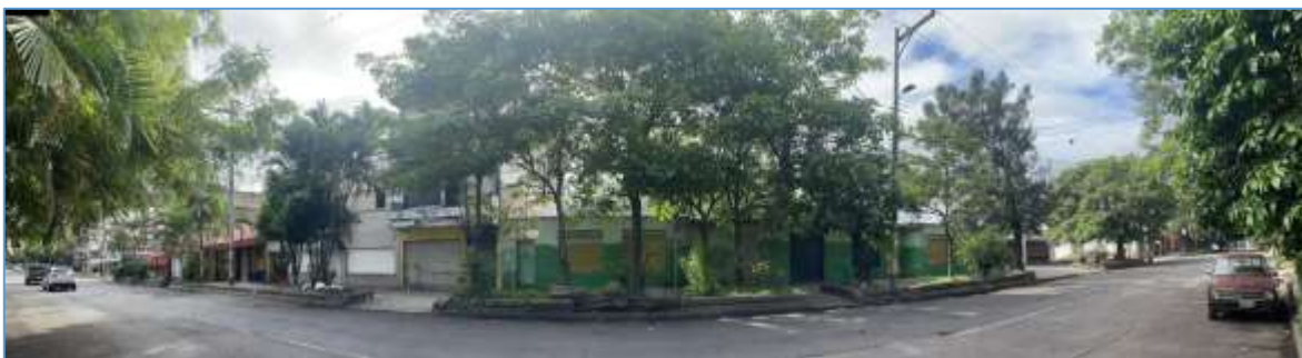
Figura 32. Panorámica de fachadas de bloque 3 Fuente: Fotografía propia. Mayo de 2022
