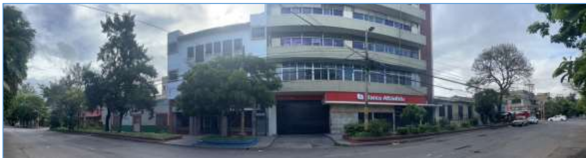
Figura 37. Panorámica de fachadas de bloque 5 Fuente: Fotografía propia. Mayo de 2022.
