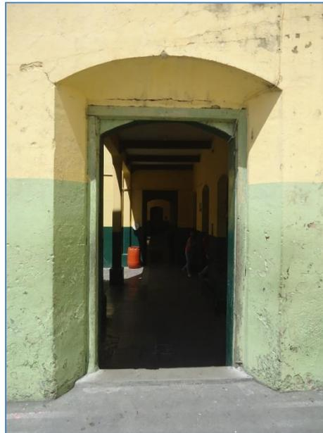
Figura 270. Arco tendido con derrame, planta baja. Casa Medrano. Nótese el espesor de los muros. Fuente: J. Cáceres, 2019.
