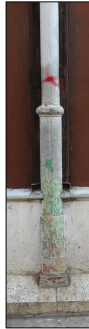
Figura 569. Apoyos metálicos portantes utilizados en la infraestructura del edificio.
