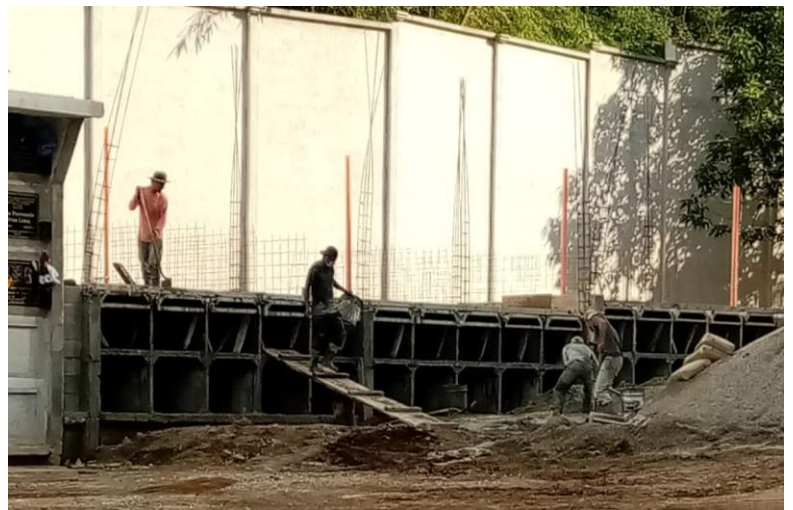
Figura 41. Proceso de construcción de nichos Fotografía Paola Orellana
