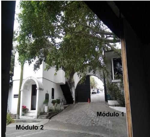
Figura 37. Ingreso y áreas administrativas y de servicio. Fotografía Paola Orellana
