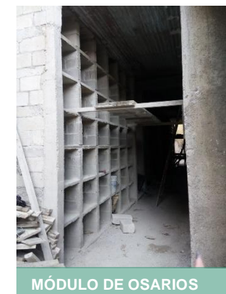
Figura 42. Proceso de construcción de nichos y Mausoleos Fotografías Paola Orellana
