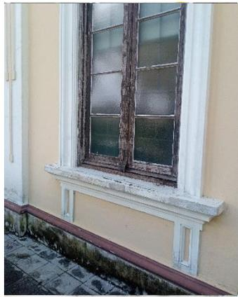
**Fotografía 177:** Daños en varios elementos exteriores, ventanas, zócalos, etc. Elaboración propia. 24 de junio de 2021.
