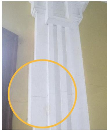
**Fotografía 126:** Microfisuras en muros y columnas. Elaboración propia. 24 de junio de 2021.
