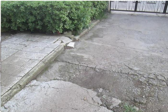
**Fotografía 197:** Rotura de piso exterior cerca de la fachada principal del Laboratorio Bacteriológico. Elaboración propia. 24 de junio de 2021.
