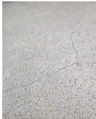
**Fotografía 137:** Agrietamiento en pisos de granito. Elaboración propia. 24 de junio de 2021.
