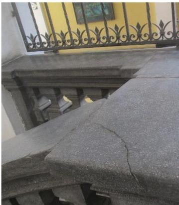
**Fotografía 136:** Agrietamiento en bases de barandilla de granito. Elaboración propia. 24 de junio de 2021.
