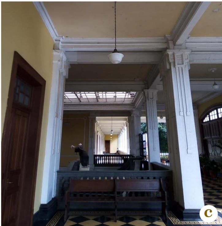
El sistema constructivo utilizado fue un sistema masivo moderno, específicamente marcos rígidos (losas, vigas y columnas) tomando en cuenta que los muros también son de carga y son de ladrillo, puesto que los elementos estructurales son de concreto reforzado siendo una de las nuevas tecnologías de construcción en ese tiempo.
