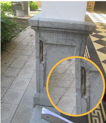
**Fotografía 128:** Agrietamiento en bases de columnas de granito. Elaboración propia. 24 de junio de 2021.
