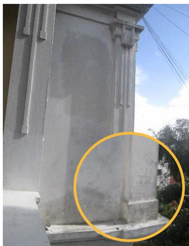
**Fotografía 117:** Humedad por filtración en muros. Elaboración propia. 24 de junio de 2021.
