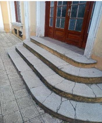
**Fotografía 176:** Piso agrietado en gradas exteriores del edificio. Elaboración propia. 24 de junio de 2021.
