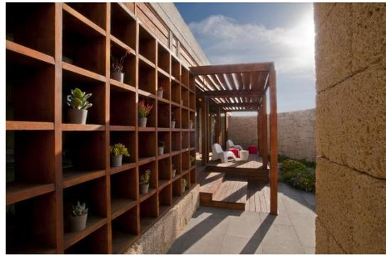
Tecnológicas constructivas: cerramiento de protección solar de lamas de madera, protegido con geotextil térmico.
