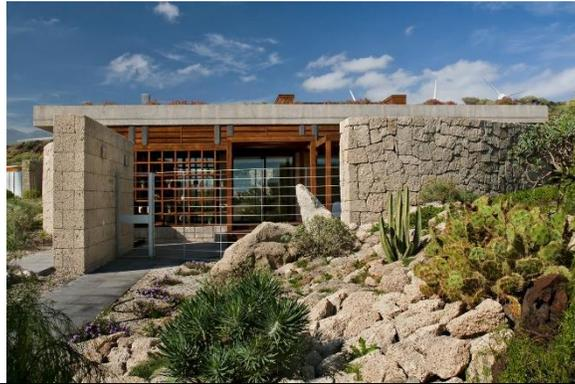
Funcionales: muros estabilizadores bioclimáticos, de doble hoja, con cámara interior de ventilación y rejillas disipadoras de aire móviles y regulables a manualmente.
