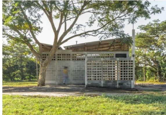
Ambientales: integración de vegetación a diferentes alturas para permitir el flujo del aire fresco a la vivienda, además de obtener microclimas confortables para los usuarios.
