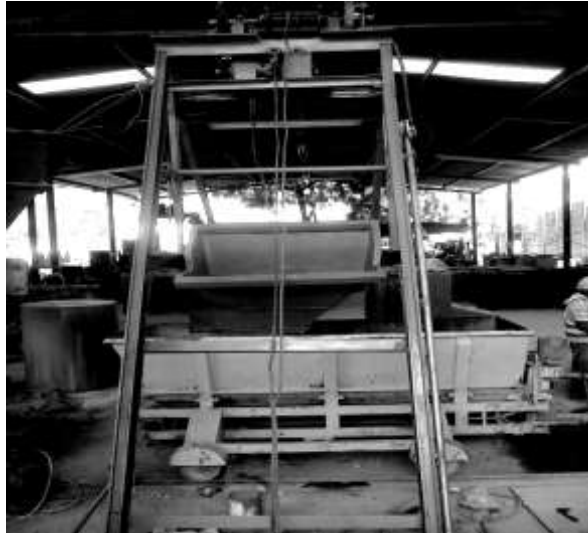
Figura 41. Skip y guías instaladas
