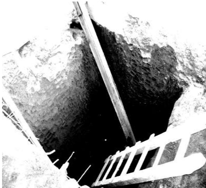
Figura 29. Fosa para cimentación de skip
