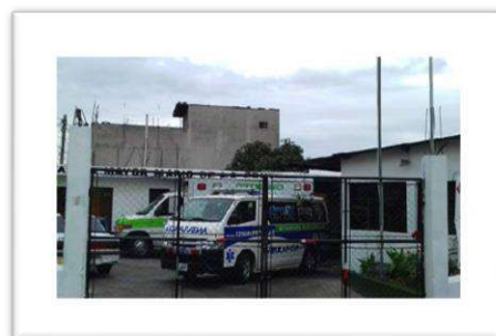
Figura 98. Estación Bomberos Municipales Departamento de Guatemala - Municipio de Villa Nueva Fuente: Google.com
