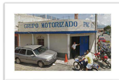
Figura 99. Sub-Estación de la Policía Nacional civil-PNC Departamento de Guatemala - Municipio de Villa Nueva Fuente: Google.com
