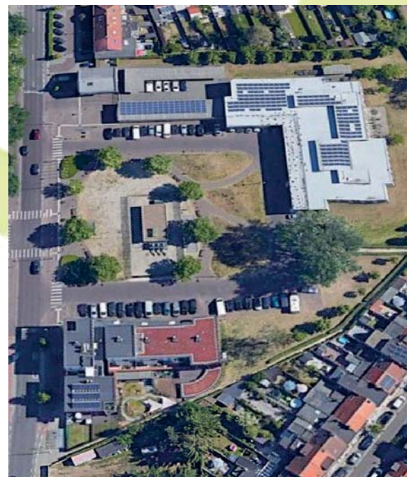
FIGURA 27 VISTA DE PAJARO DE CUARTEL DE POLICIA EN SCHOTEN FUENTE: GOOGLE MAPS
