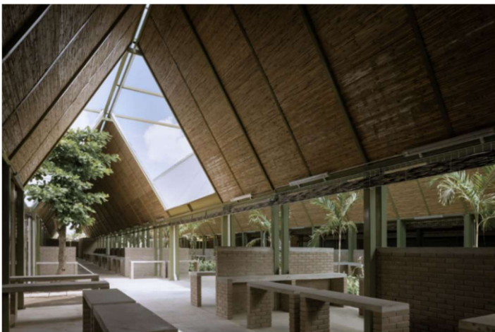
Figura No. 20 fotografía Interior Mercado Guadalupe México https://www.archdaily.com/996481/guadalupe-market-colectivo-c733?ad_medium=gallery
