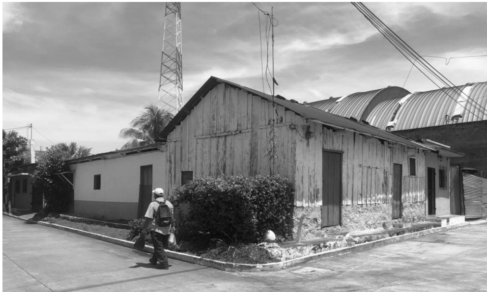
María F. Bol (2021), VIVIENDAS ANTIGUAS CON CUBIERTAS A DOS AGUAS, CON SISTEMAS CONSTRUCTIVOS DE MADERA Y HORMIGÓN Y/O CIMENTÓN CICLÓPEO.
