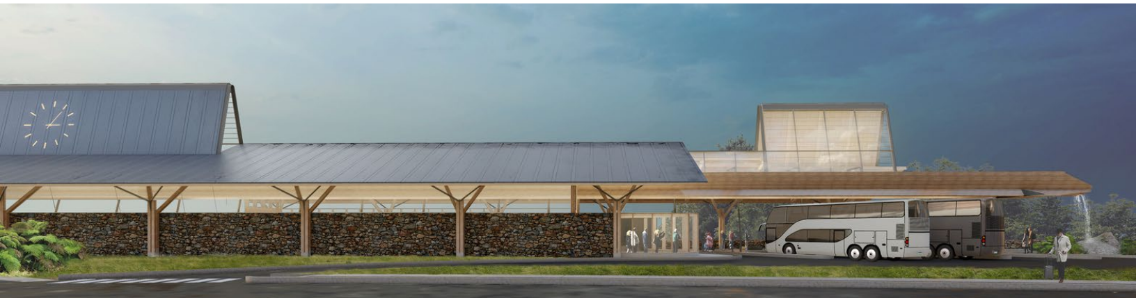
Plataforma Arquitectura (2021), TERMINAL DE PUERTO CISNES, TERMINAL RODOVIARIO, CHILE.
