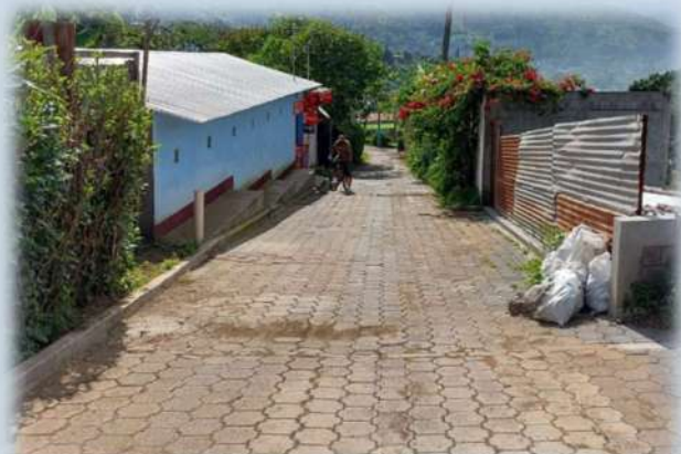
Imagen 92. Calle de acceso a terreno de proyecto. Fuente propia.
