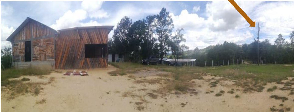
Figura 84. Vista panorámica de las instalaciones actuales, con indicación de ubicación de poste de luz con transformador.
