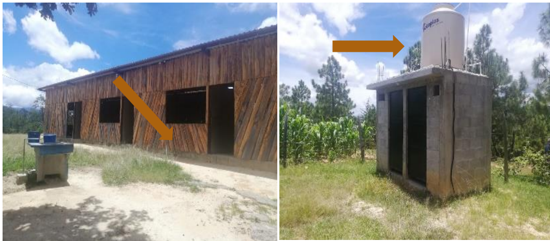
Figura 58. Tanques de almacenamiento de agua potable existentes en el terreno. Fuente: Fotografías propias
