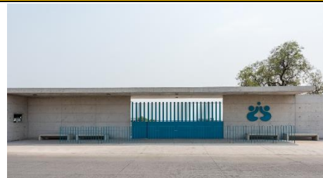
Figura 36. Ingreso al club de niños y niñas. Fuente: Club de Niños y Niñas | CCA, acceso el 02 de febrero de 2021, https://www.arquine.com/club-de-ninos-y-ninas-cca/
