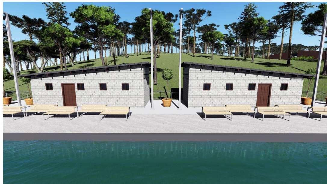
VISTA PISCINAS Y VESTIDORES
