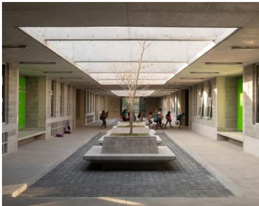
Figura 30. Edificio educativo. Fuente: Club de Niñas y Niños, finalista Obra del Año 2019. Obras expansión, acceso el 21 de febrero de 2021, https://obras.expansion.mx/construccion/2019/07/15/club-de-ninas-y-ninos-finalista-obra-del-ano-2019
