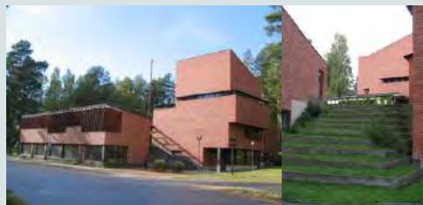
Figura 15. Edificio Municipal de Saynatsalopor Alvar Aalto. Luke Fiederer. 18 de junio, 2018. https://www.plataformaarquitectura.cl/cl/896530/clasicos-de-arquitectura-ayuntamiento-de-saynatsalo-alvar-aalto
