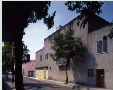
Figura 18. Casa Luis Barragán. Fundación de Arquitectura Tapatía Luis Barragán A.C. http://www.casaluisbarragan.org/lacasa.html
