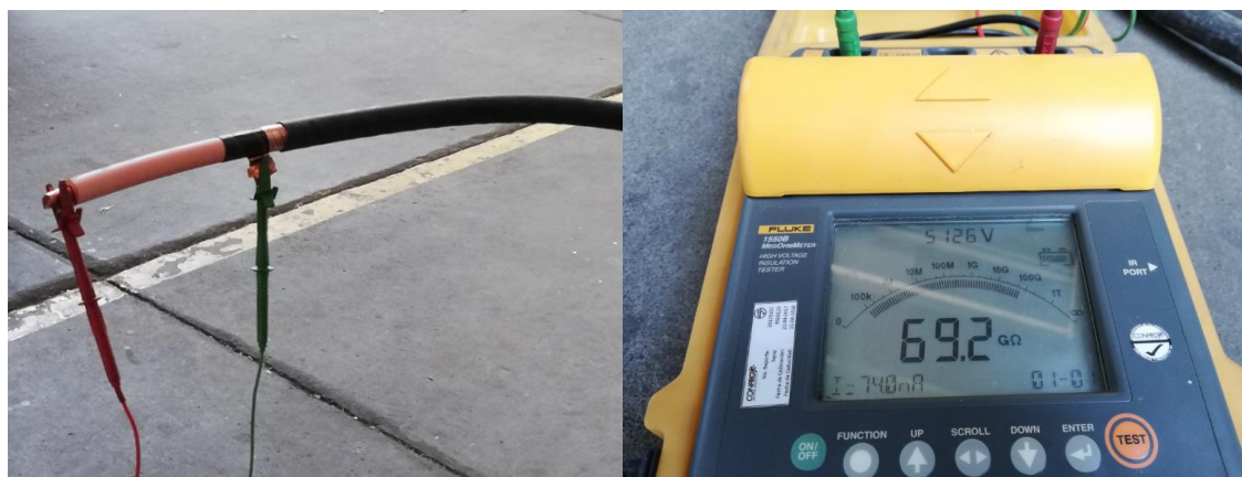
Figura 20. Ejemplo de medición de aislamiento de un cable
