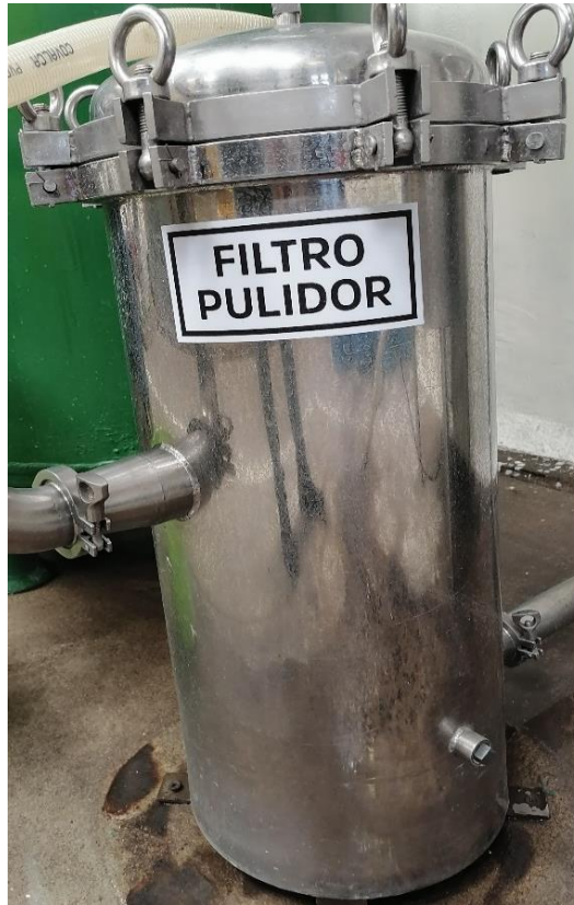
Figura 15. Filtro pulidor
