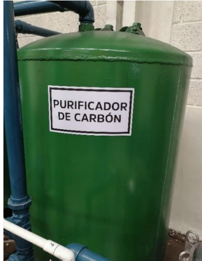
Figura 14. Filtro de carbón
