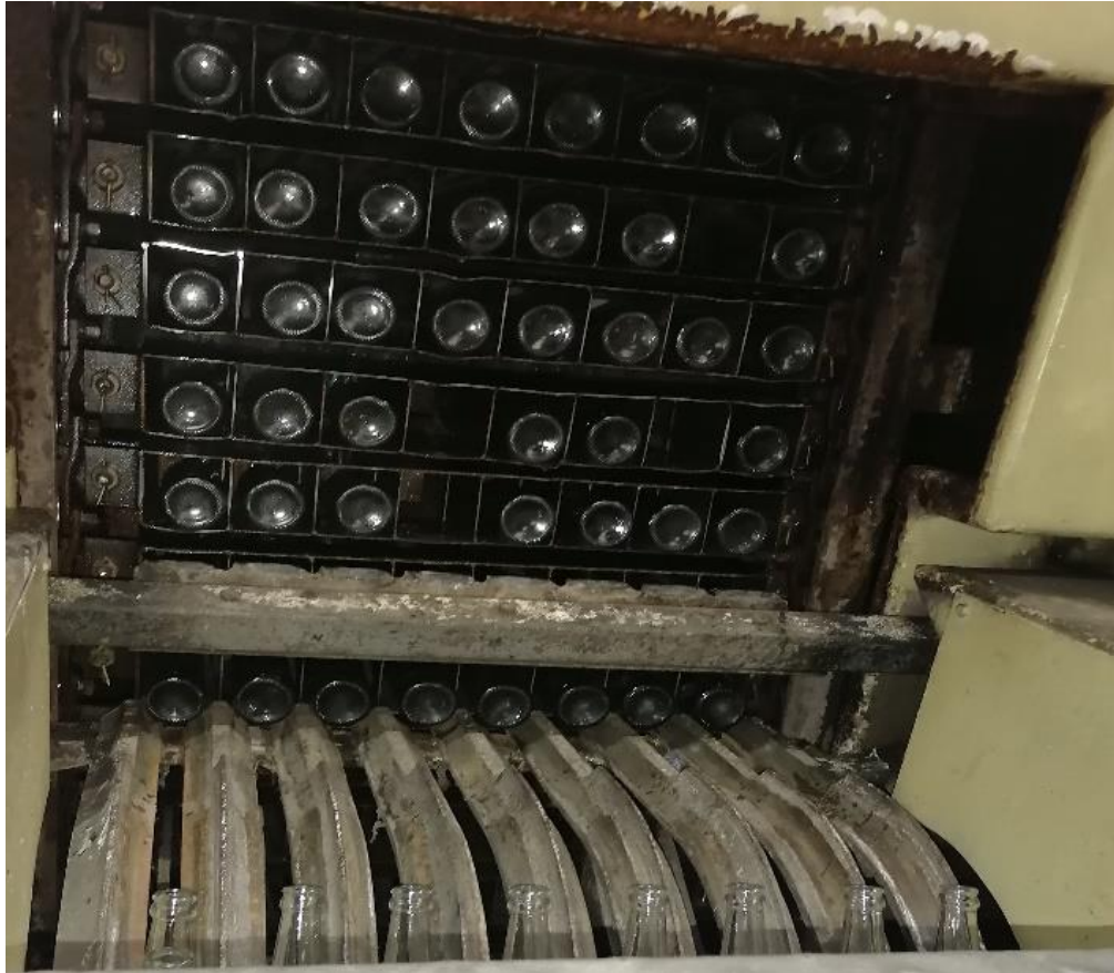
Figura 26. Ingreso al prelavado
