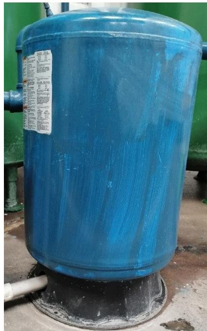
Figura 18. Tanque presurizado
