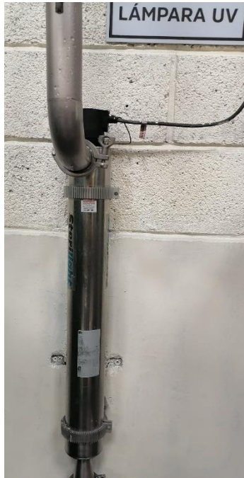
Figura 16. Luz ultravioleta
