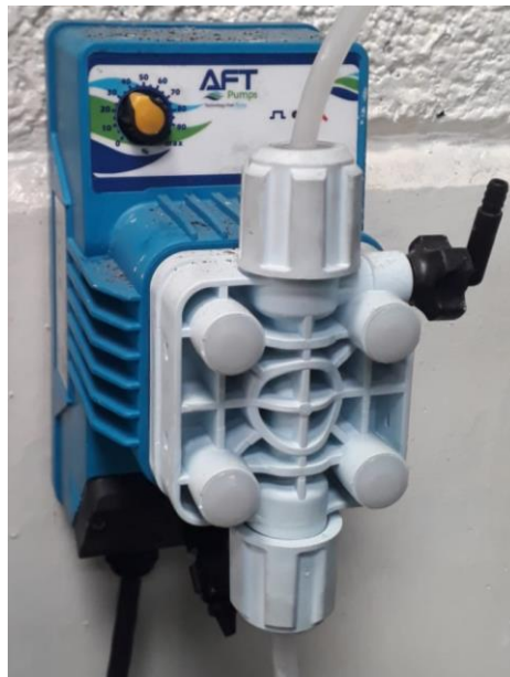
Figura 19. Bomba dosificadora
