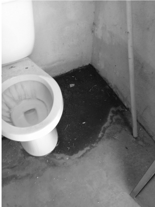
Figura 115. Baño fuera del comedor del área de caprinos
