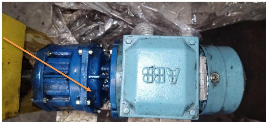
*Nota.* Motor eléctrico del mecanismo de transmisión de potencia, donde se evidencia la mala remoción de excedentes. Elaboración propia.
