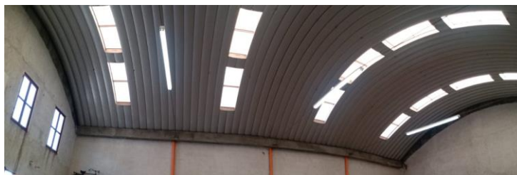
Figura 30. Luminarias Área de Empaque/Control de Calidad
