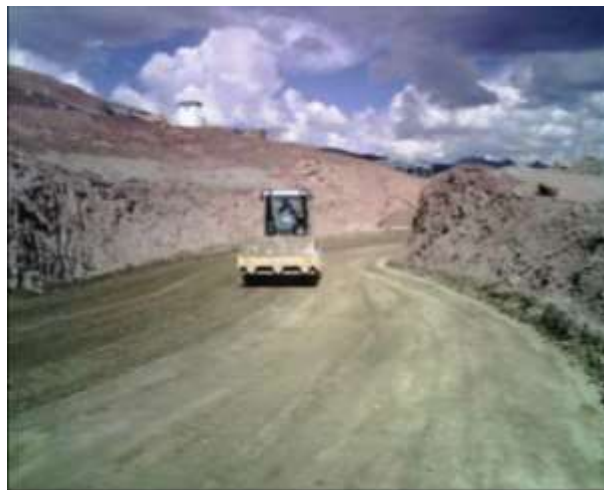
Figura 3. Compactación en la obra vial de una mina
