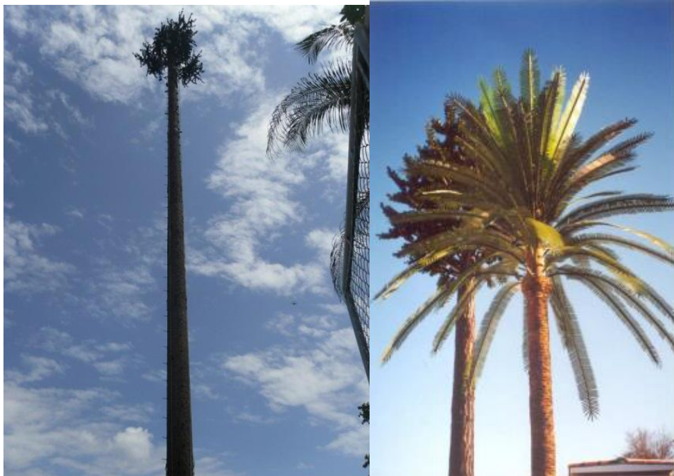
Figura 29. Mimetización de torre
