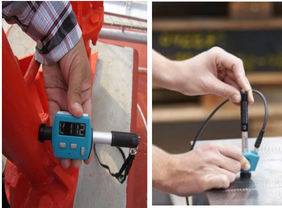
Figura 19. Medición de dureza en montante de torre
