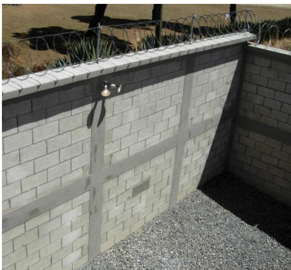
Figura 9. Muro de cerramiento con block
