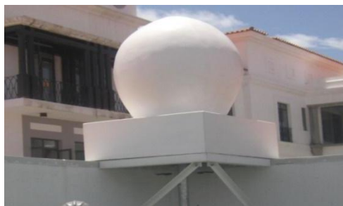
Figura 10. Mimetización en fibra de vidrio
