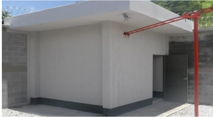
Figura 30. Pintura en caseta
