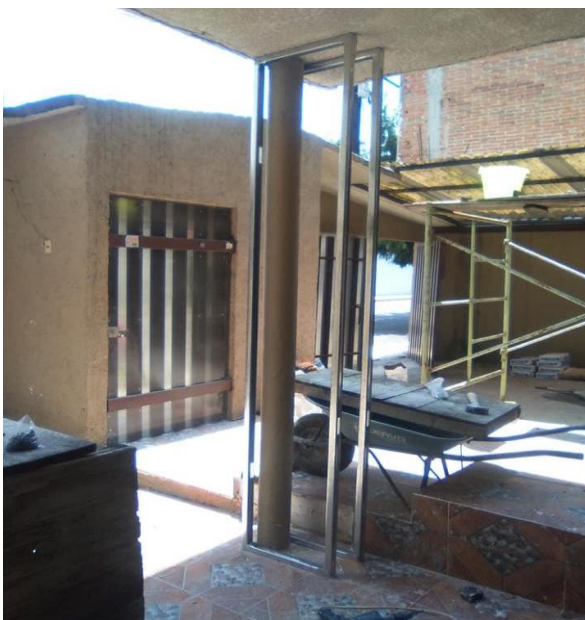
Figura 13. Cerramiento de mimetización tipo columna con durock
