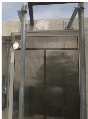
Figura 11. Mimetización de ventana con lámina de policarbonato
