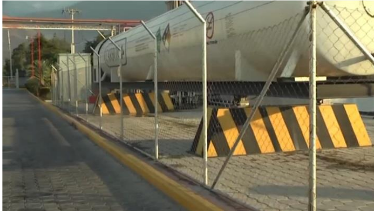
Figura 3. Tanque pulmón de gas carbónico (CO 2 )
