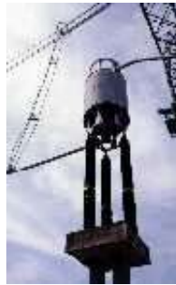
Figura 11. Trampa de onda sobre aisladores
