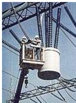
Figura 10. Trampa de onda suspendida por cadenas
