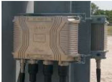
Figura 20. Brick montado en el equipo de patio
