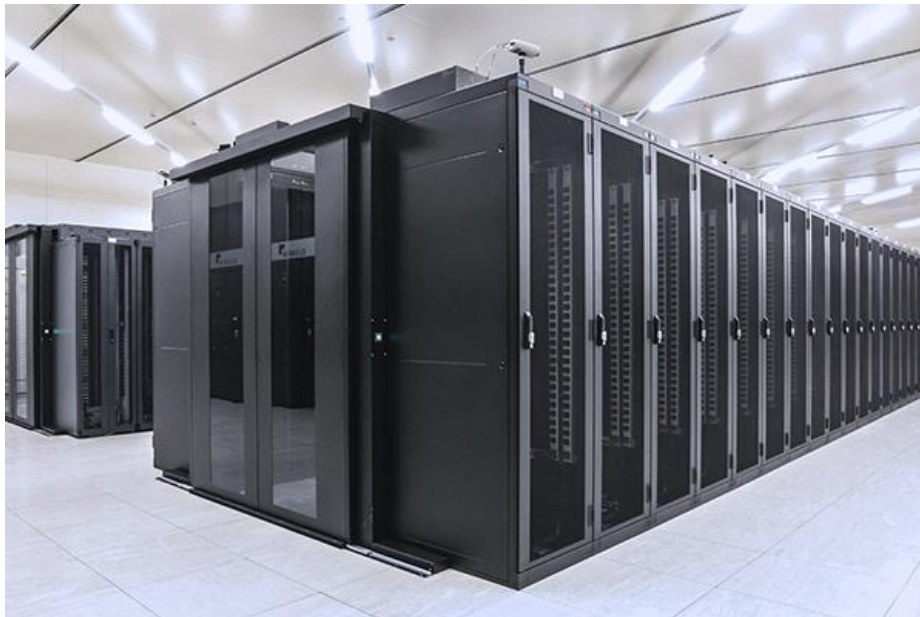
Figura 2. Centros de datos confinados por bahías
