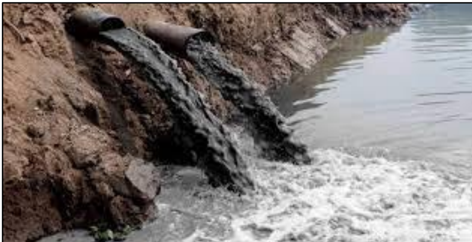
Figura 2. Contaminación de fuentes de agua con aguas residuales
