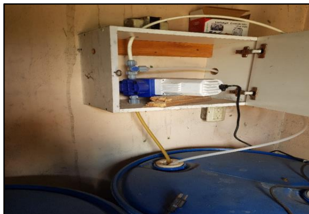
Figura 18. Bomba de inyección rotativa
