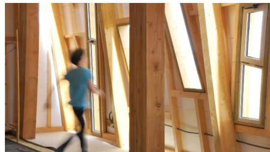
Ilustración 38. Vista Interior EVOA Centro de Interpretación Ambiental Publicado por Arch Daily, 2009, https://www.archdaily.cl/cl
