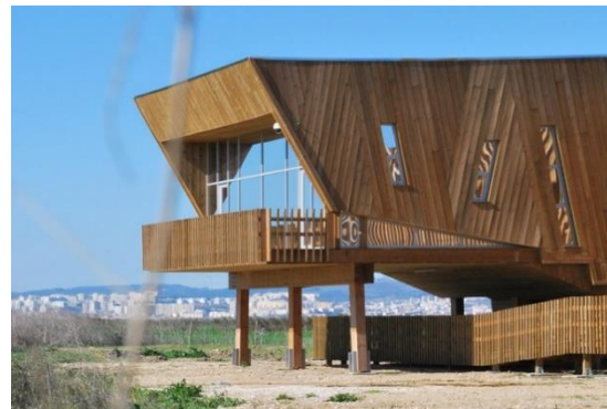
Ilustración 37. Estructura EVOA Centro de Interpretación Ambiental, Publicado por Arch Daily, 2009, https://www.archdaily.cl/cl
