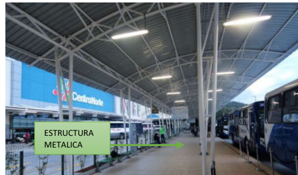
Figura 36 Aspectos Constructivos Central Norte.
