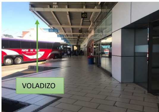
Figura 35 Aspectos Constructivos Central Norte.
