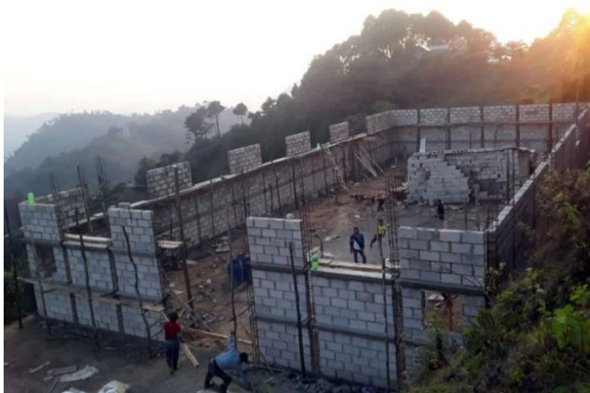
Figura 31: Construcción escuela (Fuente 2021. "Portal De información Pública". MuniPurulha.Laip.Gt. https://www.munipurulha.laip.gt/ ).
