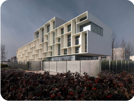
Ilustración 16 - Oficina Central Bentini / Piuarch. Plataforma arquitectura. https://bit.ly/3OCu9m6
