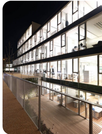
Ilustración 17 - Oficina Central Bentini / Piuarch. Plataforma arquitectura. https://bit.ly/3OCu9m6
