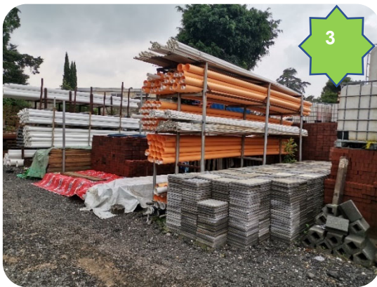
Ilustración 37 - Almacenamiento de tuberías. Imagen propia.
