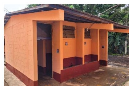
Imagen 1.17 Fotografía final de Dania Crúz (Oratorio, Santa Rosa 2022). Archivos de Ejercicio Profesional Supervisado en San José Las Cabezas, Oratorio, Santa Rosa. Nota: El exterior de los baños ya con el trabajo de pintura terminado.
