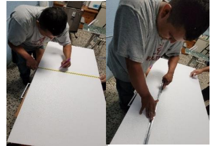
Imagen 1.39 y 1.40 de Dania Cruz (Oratorio, Santa Rosa 2022). Archivos de Ejercicio Profesional Supervisado en Clínica Municipal San José Las Cabezas, Oratorio, Santa Rosa. Nota: Corte de las planchas a la medida necesaria para terminar con la colocación.
