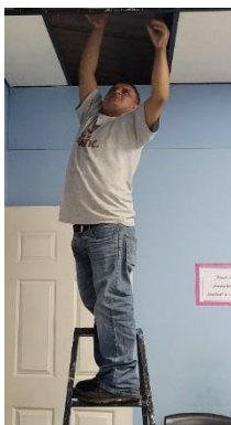
Imagen 1.34 de Dania Cruz (Oratorio, Santa Rosa 2022). Archivos de Ejercicio Profesional Supervisado en Clínica Municipal San José Las Cabezas, Oratorio, Santa Rosa. Nota: Desmontaje de las planchas viejas que estaban colocadas en el techo de la clínica.
