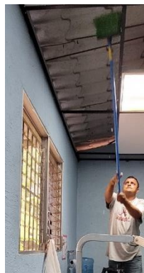
Imagen 1.35 de Dania Cruz (Oratorio, Santa Rosa 2022). Archivos de Ejercicio Profesional Supervisado en Clínica Municipal San José Las Cabezas, Oratorio, Santa Rosa. Nota: Limpieza de la estructura del cielo falso después del retiro de las planchas.
