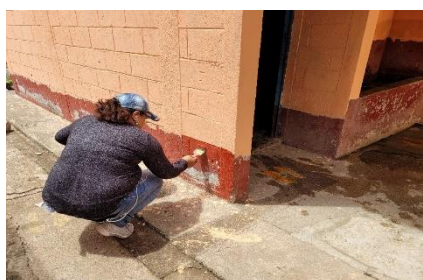
Imagen 1.15 de Dania Crúz (Oratorio, Santa Rosa 2022). Archivos de Ejercicio Profesional Supervisado en San José Las Cabezas, Oratorio, Santa Rosa. Nota: Se realizó sócalo con pintura de aceite en el interior y exterior de los baños.
