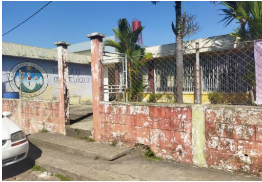
Imagen 5: Parte exterior del Módulo antes de ser pintada.
