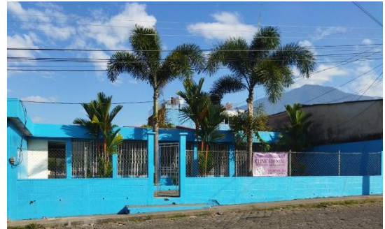
Imagen 6: Parte exterior del módulo después de haber sido pintada.
